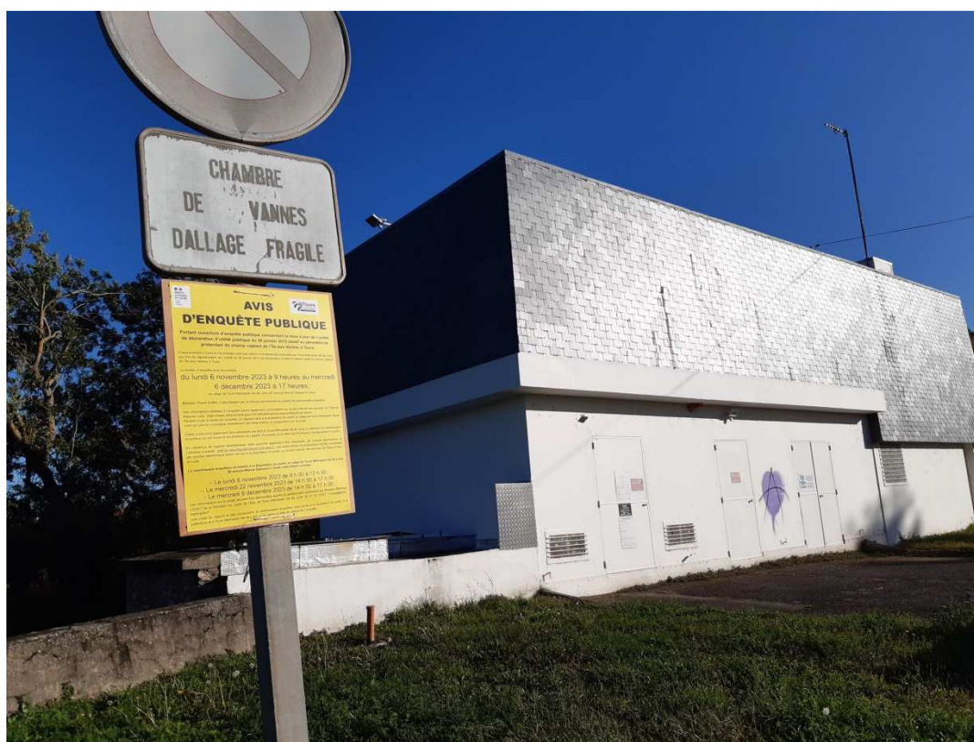
Station de pompage du Val fleuri
