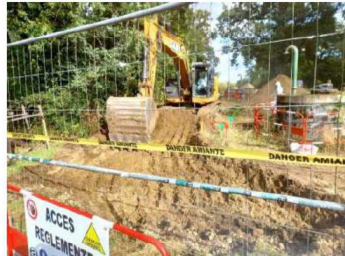
Ramassage des débris par pelle mécanique
