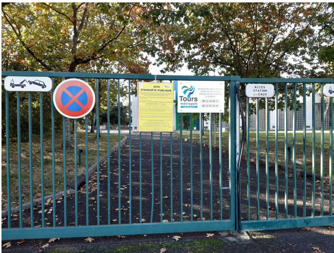
Portail d'accès au réservoir de « la gare du canal »
